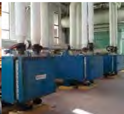
Réchauffeur de jus de sucrerie multi-circuits
