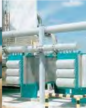
Refroidisseur d'effluents d'industrie papetière
