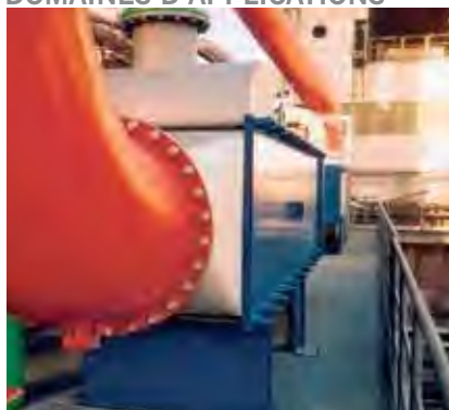
Condenseur vapeur basse pression
