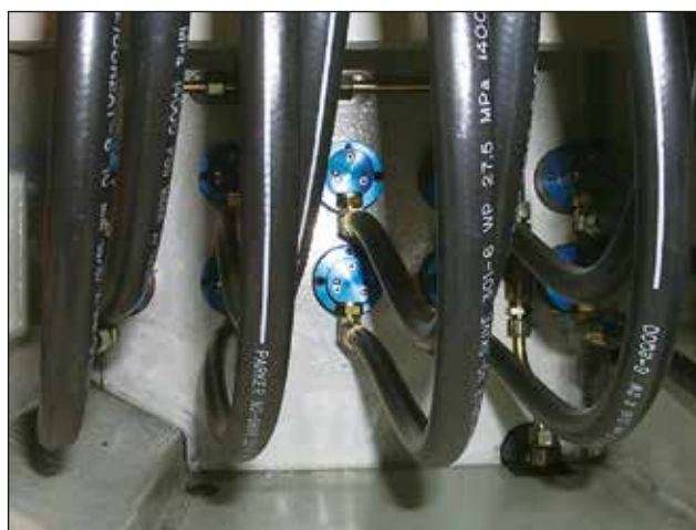
Joints Tournants DEUBLIN 1117 sans roulement sur ligne transfert automobile.
