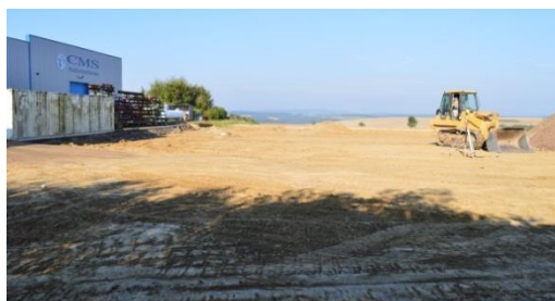
Début du nouveau chantier pour 1200 m 2 de plus mi-septembre 2016.
