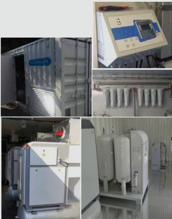
Intégration d'une unité de production en conteneur
