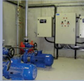
Une installation de **pompage** réussie nécessite l'étude et la mise en œuvre de différents équipements dont : les pompes, les armoires de commande et de régulation, les réservoirs, la robinetterie, l'instrumentation, la télétransmission...
