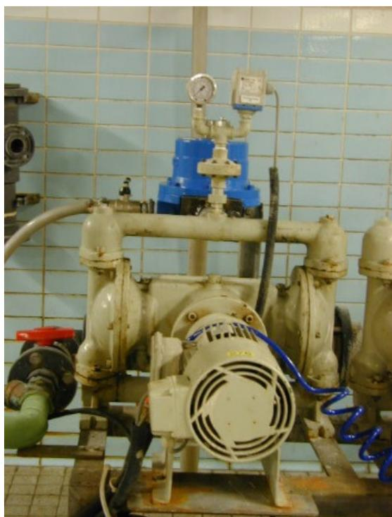
Transfert du lait de chaux avec la pompe électromécanique EM
