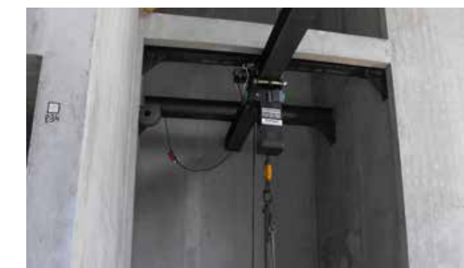
Installation sur-mesure au-dessus d'une tremie d'un palan sur fer
