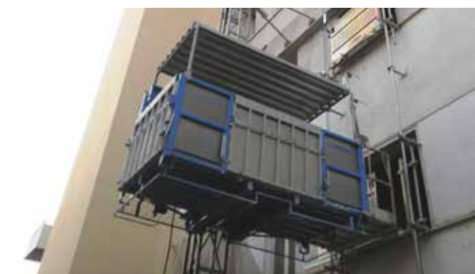
Installation d'un monte-charge avec accompagnant sur bâtiment.
