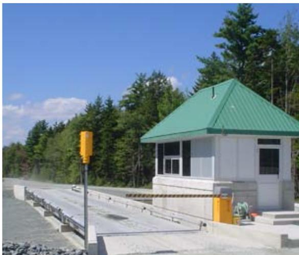
Pont-bascule simple et guérite de pesage
