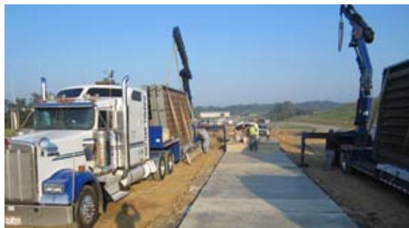
Spécialement conçus, les camions de livraison sont en mesure de transporter les modules de la plateforme en position verticale.
