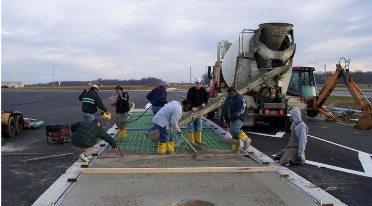
Le béton est coulé dans le tablier d'une plateforme en béton lors de l'installation.
