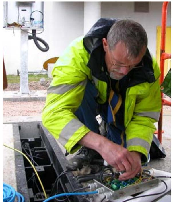
Un technicien teste les raccords des câbles de la cellule de pesée à l'intérieur d'une boîte de jonction
