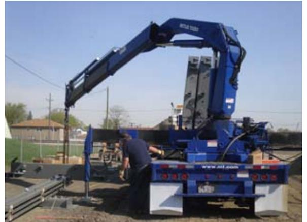
Assemblage du châssis d'un pont-basculé pour camions portable sur un site préparé où le sol a été compacté
