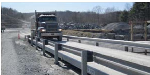
Ces glissières de sécurité autonomes sont plantées dans le sol le long du pont-bascule pour conférer une résistance supplémentaire et empêcher les camions de circuler sur le côté du pont-bascule.
