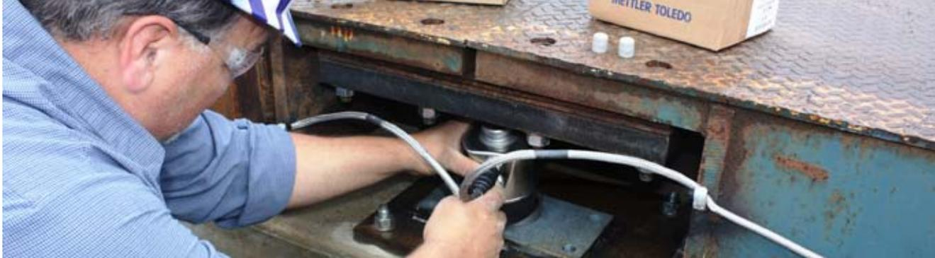
La mise à niveau d'une plateforme existante en installant un nouveau système de cellules de pesée améliore la précision et la fiabilité du pont-bascule.
