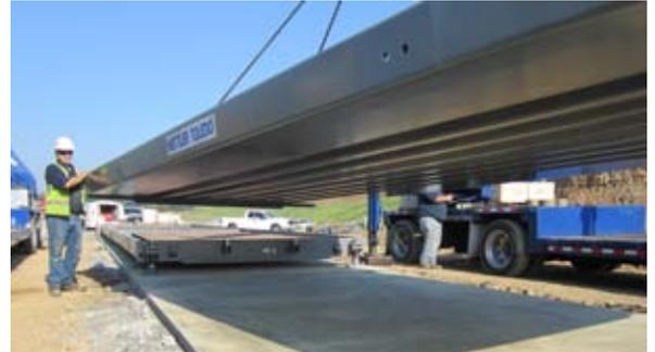
Les modules de la plateforme sont placés dans les fondations
