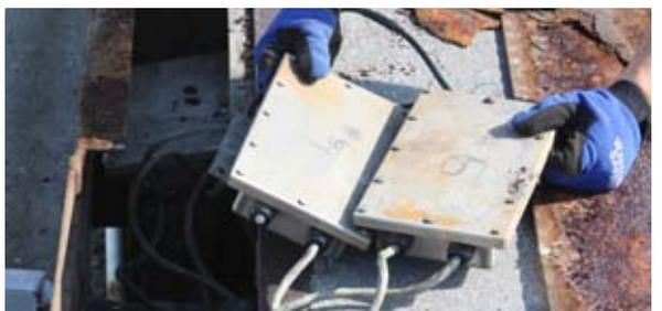
Les boîtes de jonction contiennent des cartes à circuit imprimé et de nombreux fils raccordés manuellement. Elles sont la principale cause des temps d'arrêt des ponts-bascules pour camions, car il est difficile de les rendre étanches à l'humidité
