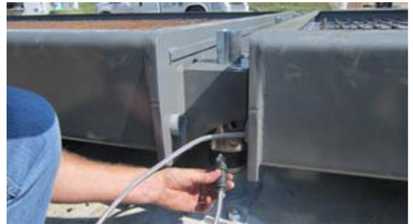
Les câbles de la cellule de pesée sont acheminés à travers le pont-basculé et raccordés aux cellules de pesée
