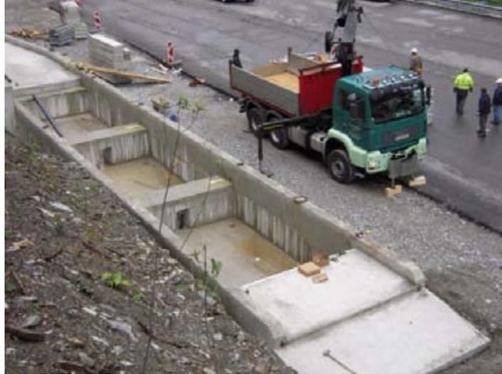
Les fondations du pont-bascule doivent comprendre des approches adaptées, conformes aux réglementations locales
