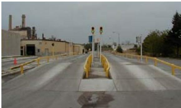
Des glissières de sécurité montées sur le pont-bascule sont fixées sur le côté des modules de la plateforme à l'aide de boulons ou de supports soudés
