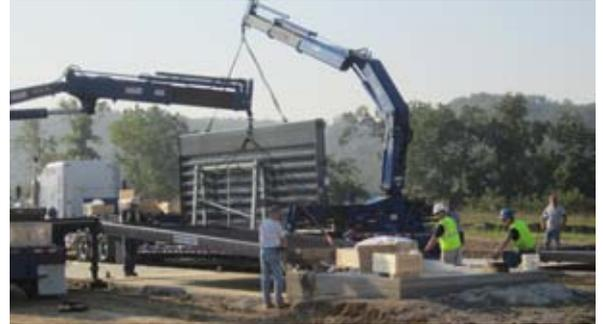
Ces camions de livraison des ponts-basculés sont équipés de grues embarquées qui permettent de soulever et placer les modules de la plateforme dans les fondations du pont-basculé.
