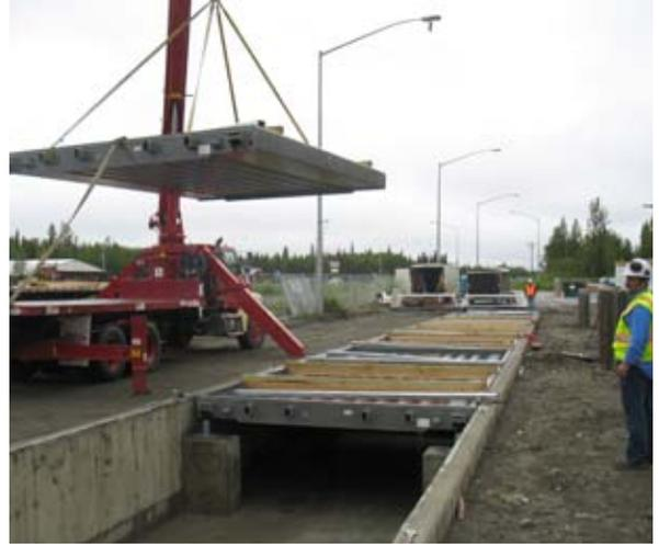
Un pont-bascule encastré dans une fosse est placé dans les fondations creusées, au ras du sol.
