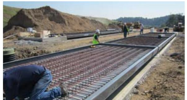
Ce pont-basculé est presque prêt à recevoir la chape de béton dans les modules du tablier
