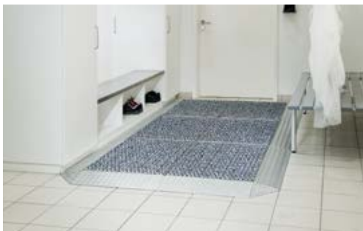
Installation de ProfilGate® b55 go sur le sol avec des rampes
