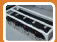
Parc batteries AGM ou OPZV étanches sans entretien. OPZS en option.
