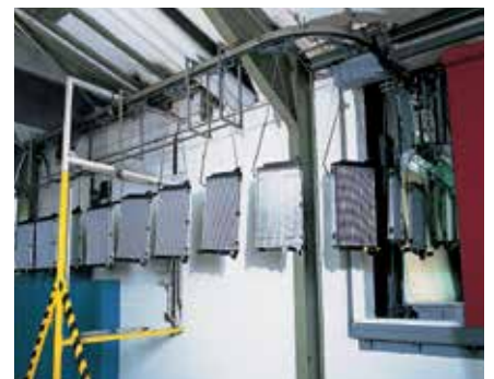
Mise en peinture électrostatique
