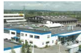
Autokühler GmbH & Co. KG Appenweier, Allemagne
