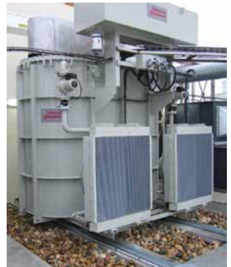
Refroidisseur d'huile stationnaire pour transformateurs, Bernard & Bonnefond
