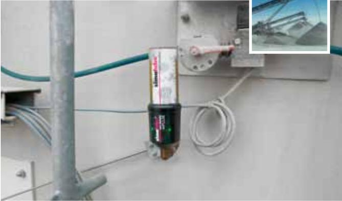
Le simalube IMPULSE avec un graisseur 125 ml est utilisé dans les usines de gravier. L'IMPULSE pousse le lubrifiant avec une pression de 10 bar à travers une tube de 4 mètres.
