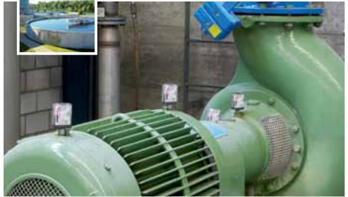
Des graisseurs 60 ml sur le moteur électrique et sur l'arbre de transmission assurent une lubrification continue d'une pompe centrifuge.
