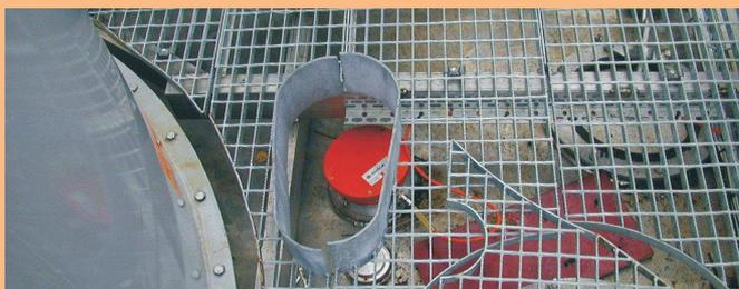
Le détecteur MGD agréé FM offre une solution pour la détection précoce des différents types de gaz à l'origine des incendies ou explosion dans des environnements industriels difficiles tels que les silos, les entrepôts, les installations portuaires, les zones de production industrielle, etc.
