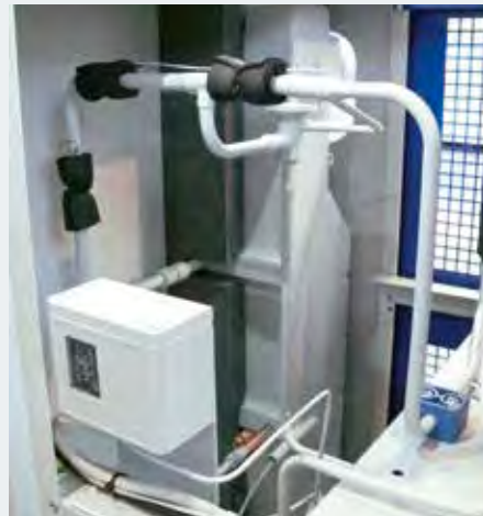
Vues intérieures d'un sécheur frigorifique avec revêtement anticorrosion
