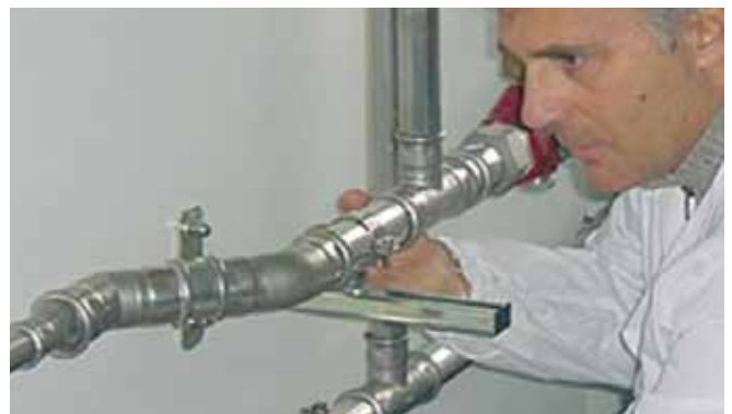
Image 33 - Vérification du sertissage
