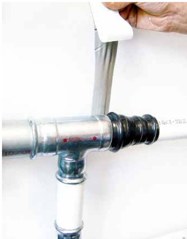
Image 35 - Protection des raccordement avec la bande adhésive
