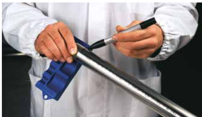
Image 28 - Marquage de la profondeur d'emboîtement
