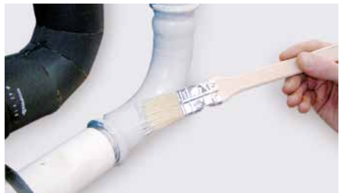
Image 34 - Application du vernis primaire sur les conduites avec enduit
