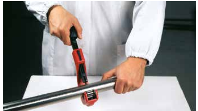
Image 25 - Mise à longueur des tubes
