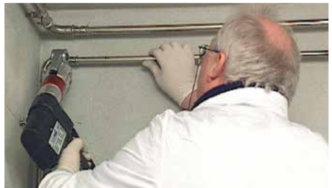
Image 32 - Réalisation du sertissage
