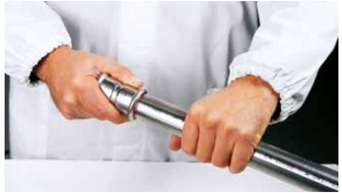
Image 31 - Introduction du tube dans le raccord
