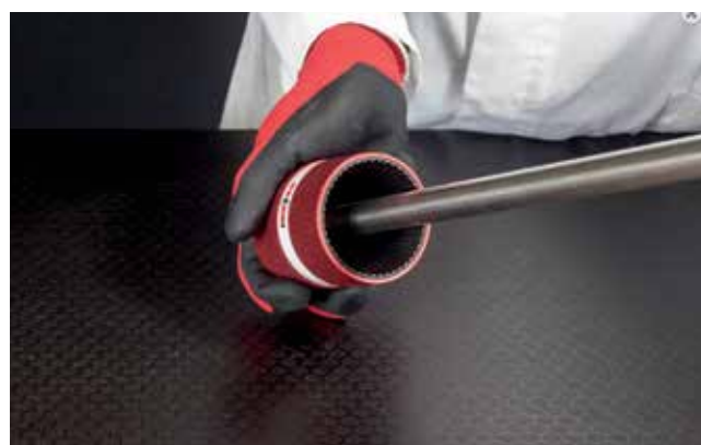
Sbavatura del tubo / Deburring the pipe
