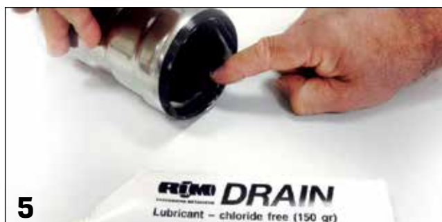
5 Lubrificazione zona interna guarnizione / Internal gasket lubrication
