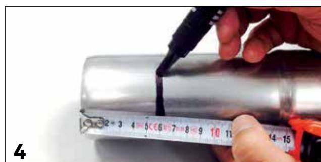
4 Marcatura quota d'innesto / Marking the insertion's depth
