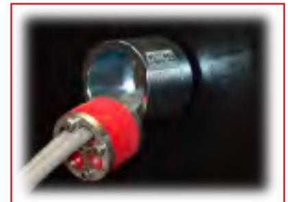
3 - Tirer les câbles dans le fourreau et la bague
