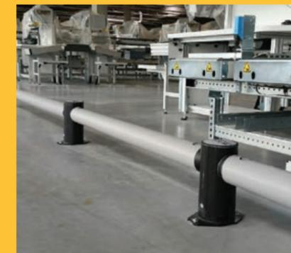
Barrière Single Traffic mFlex guidant les véhicules et en limitant l'accès à une ligne de production.
