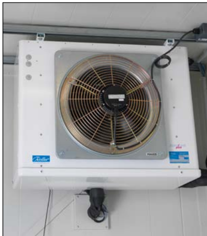
Climatisations split avec groupes frigorifiques (vue intérieure)
