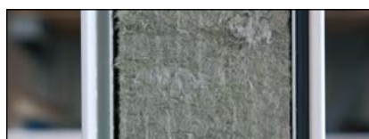
Isolation des parois en laine de roche
