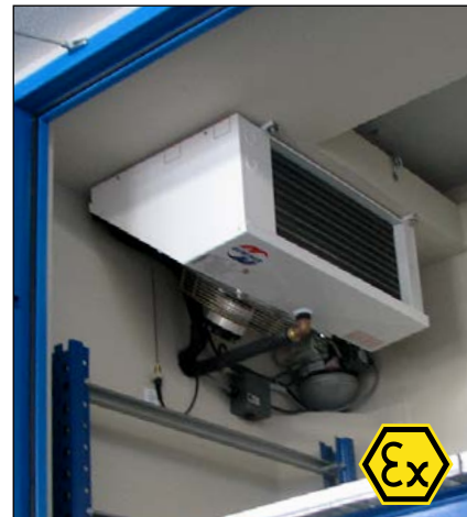
Climatisations split avec groupes frigorifiques (vue intérieure) en version ATEX
