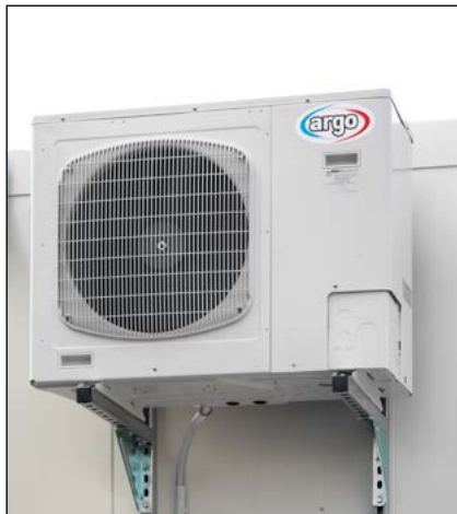
Climatisations split avec groupes frigorifiques (vue extérieure)
