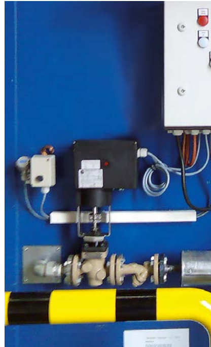
Chauffage à vapeur avec régulation de température, électrique
