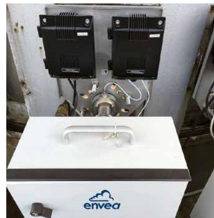
MESURE CONTINUE DU DÉBIT DE GAZ
