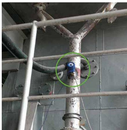
MESURE DE DÉBIT DE FAIBLE QUANTITÉ DE MATIÈRE
