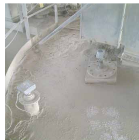
MESURE DE NIVEAU DANS DES SILOS
