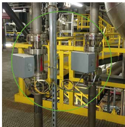
MESURE DE DÉBIT EN TRANSPORT PNEUMATIQUE
