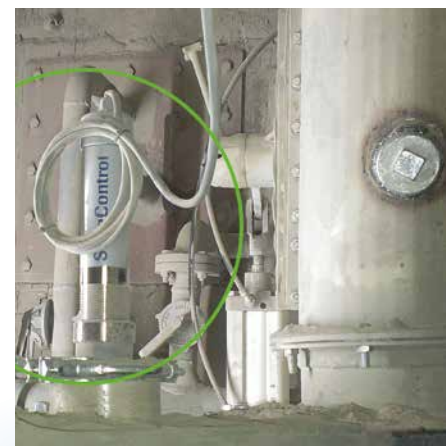
MESURE DE DÉBIT EN AÉROGLISSIÈRE
