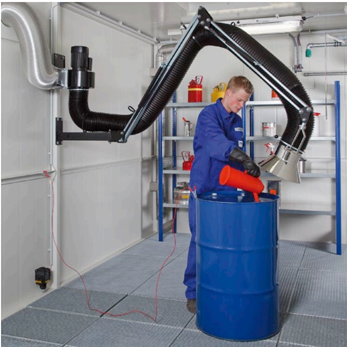
Salle de transfert avec bras d'aspiration intégré pour l'extraction ponctuelle des vapeurs dangereuses pour la santé
