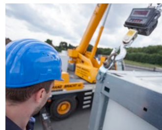
Le conteneur de stockage résiste aux contraintes
