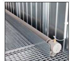
Convecteur électrique avec protection anti-choc
