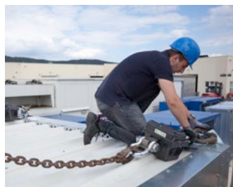
Le conteneur de stockage est préparé pour le grutage
