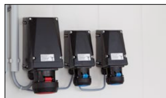
Prises électriques pour les branchements sécurisés d'autres appareils (230 V ou 400 V, 50 Hz).
