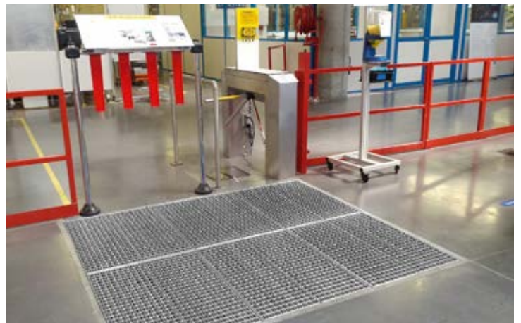
Nettoyage de semelles avec ProfilGate® st55 go devant le secteur ESD
