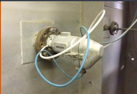
Le pyromètre infrarouge permet d'avoir une image très représentative du process pour agir de manière optimale sur la régulation de volume de NOx ou du CO<sup>2</sup>.
