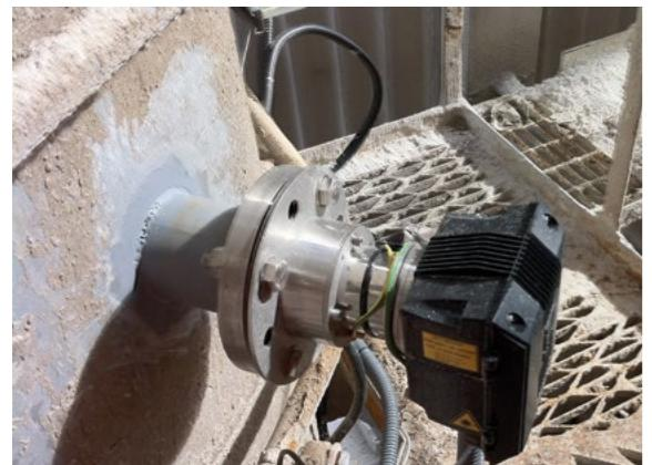
Le QAL 181/360 boucle la gamme des capteurs de poussières car il fonctionne exactement là où les systèmes électrodynamiques ne servent pas, c'est-à-dire après les filtres électrostatiques et en cas de concentrations de poussières très élevées. Avec son homologation QAL 1, il est à la hauteur de son équivalent électrodynamique. Son avantage indéniable : Mise en service sans démontage du capteur. Il suffit de faire pivoter la tête du capteur sur la charnière.
