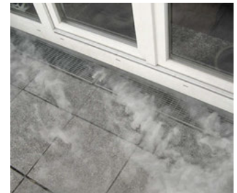
Étanchéité défectueuse d'une toiture-terrasse.
