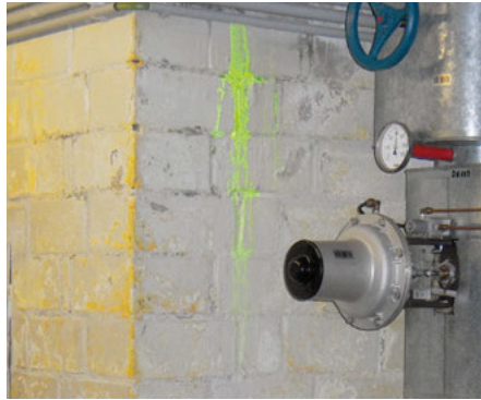
Localisation d'une conduite d'eau non étanche dans un bâtiment par injection d'urarine et inspection UV.
