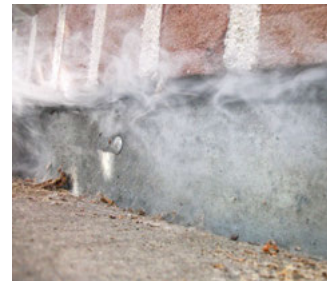
Détection de défaut d'étanchéité des joints de mur au-dessus d'un garage souterrain.
