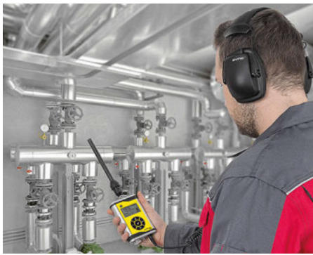
La sonde directive permet de localiser avec précision les fuites sur les conduites non couvertes.
