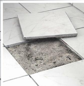
Les revêtements de sol comme le carrelage, la pierre naturelle ou le parquet sont souvent des obstacles lorsque le séchage de la couche d'isolation doit être effectué suite à un dégât des eaux.
