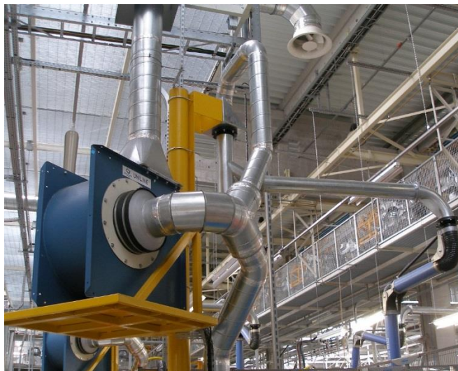
Extraction de fumées de soudure
