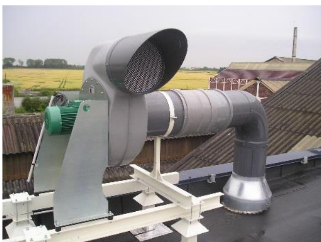
Extraction de gaz corrosifs
