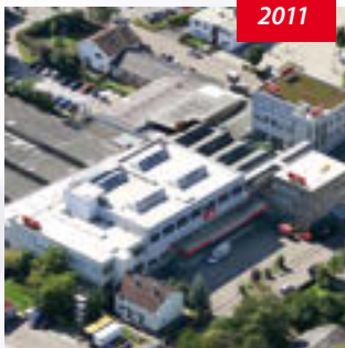
Vue aérienne du site, Bietigheim-Bissingen
