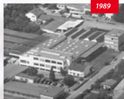
Vue aérienne du site, Bietigheim-Bissingen
